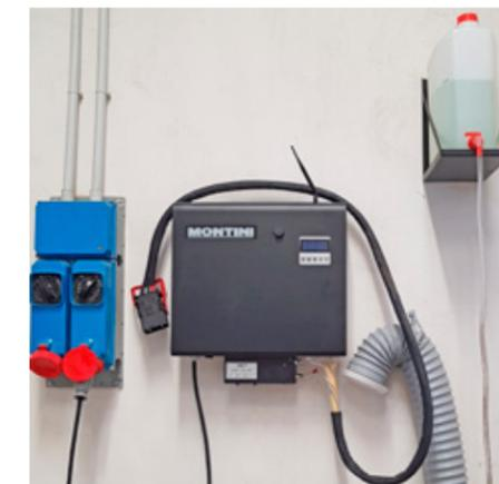
Il caricabatteria intelligente MONTINI **regola automaticamente la corrente**, in base alla capacità della batteria, memorizzando l'eventuale necessità di rabbocco dell'elettrolito.
